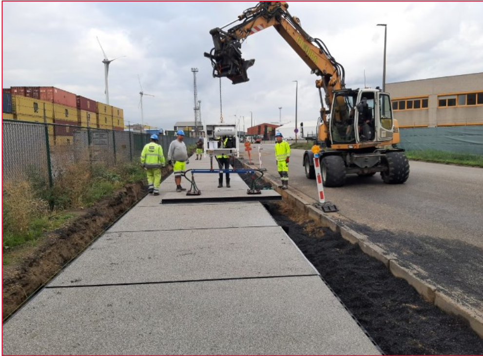
Figura 75 : Un carril bici está instalado utilizando paneles que incluyen pellets de plástico reciclado
