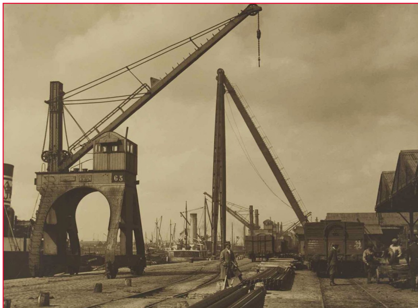
Figura 1: Grúas hidráulicas en el Kattendijkdok, alrededor de 1900. Las grúas formaron parte de una serie de innovaciones tecnológicas que elevaron las operaciones portuarias a un nivel superior.
